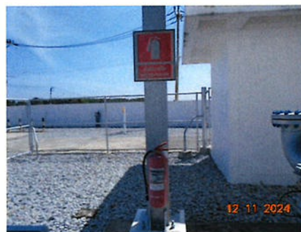
ภาพที่ 2-2 เครื่องดับเพลิงบริเวณสถานีก๊าซ บริเวณสถานีควบคุมความดันและวัดปริมาณก๊าซธรรมชาติ
